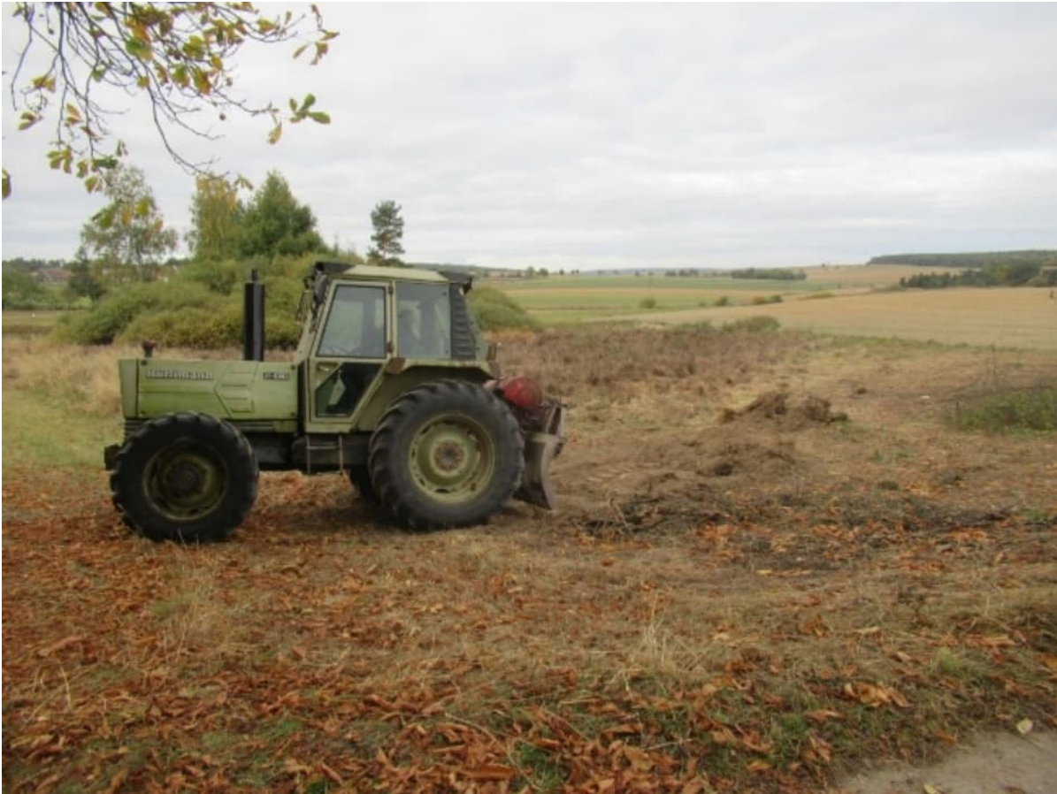
Abb. 13: Planieren eines Zufahrtweges bzw. teilweise Entfernung der Wurzelstöcke mittels Traktor mit Planierschild © G. Bassler-Binder
