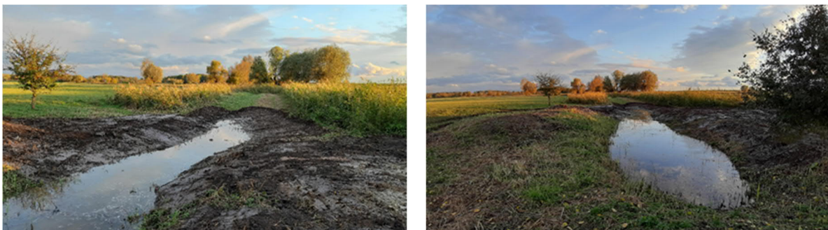
Abbildung 4: Stierwiesensutte (Kleinodnr. 01-04) nach Baggerarbeiten zur Eintiefung der Sutte. © Helm
