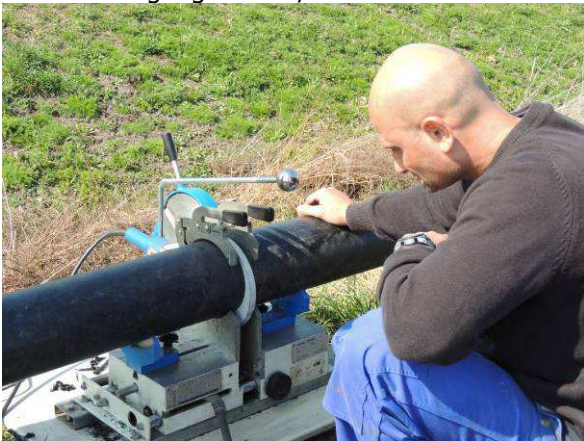
Die PE-Rohre werden an den ehemaligen Kupplungsstellen fachmännisch verschweißt, 21.3.2014.
