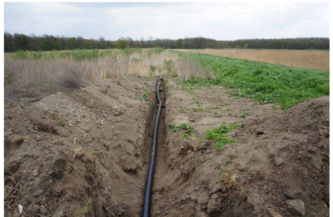
Abzweigungen reichen in alle beflutbaren Bereiche, hier ins Anlandebecken 2, 14.4.2014.
