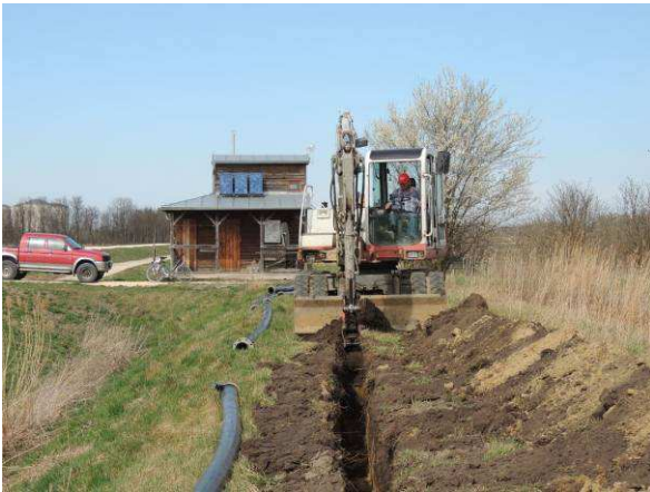
Neuverlegung der alten Rohrleitung in den Boden - hier an der Beringungsstation, 21.3.2014.
