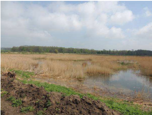
Unmittelbar nach Abschluss der Rohrverlegung wurde mit der Bewässerung im Anlandebecken 3 begonnen, 21.4.2014.
