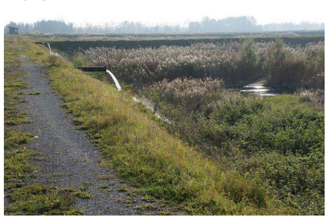
Im Spätherbst wurden die Zwischenlager zur Zurückdrängung des Schilfbewuchses und zur Schaffung ausreichender Frühlingswassermengen geflutet, 2.11.2014.
