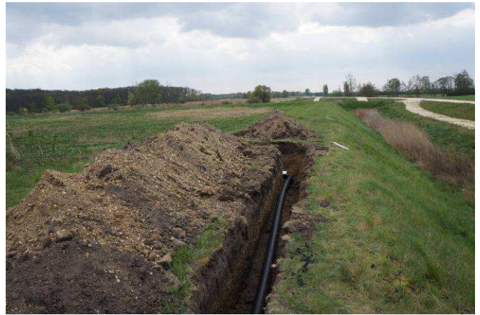
Ende der neu verlegten Leitung an Anlandebecken 10, 14.4.2014.
