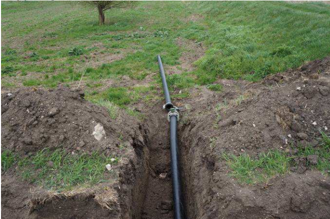
In die Becken selbst können die Leitungen über Kuppelstücke verlängert werden, 14.4.2014.
